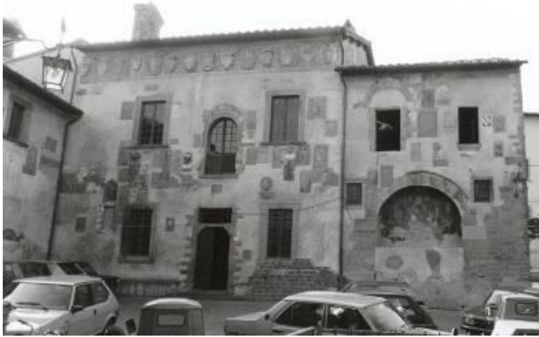
Fig. 4 - Anghiari. Palazzo Pretorio in un'immagine della fine degli anni '80 del XX secolo. Si osserva l'apertura della porta-finestra sul prospetto principale.
