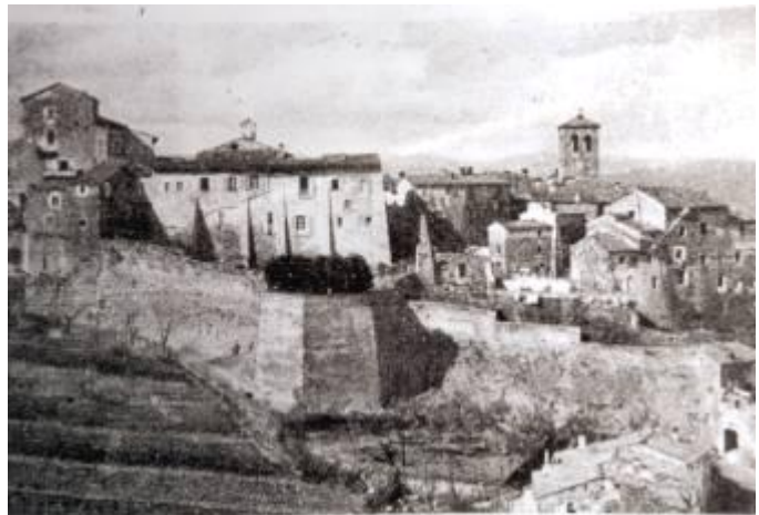
Fig. 2 - Anghiari. Palazzo Pretorio in un'immagine degli anni '30 del XX secolo. Si osservano i quattro speroni sul prospetto sud realizzati dopo il terremoto del 1917.
