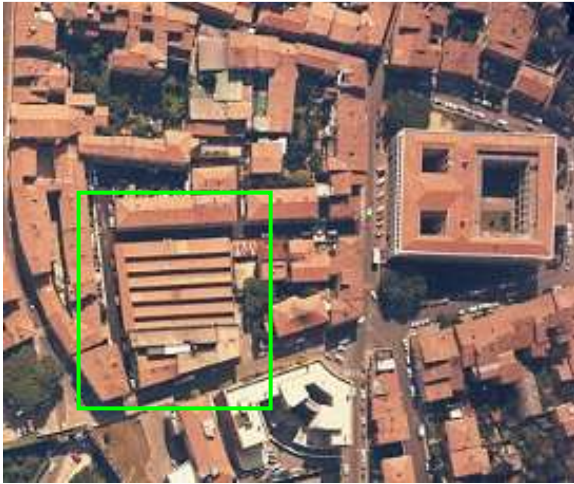
Pisa (1980). Veduta aerea dell'area oggetto di trasformazione urbana con la fabbrica manifatturiera Forest, di Foresto Bargi, realizzata nel 1934. A destra la sede del Palazzo di Giustizia realizzato su progetto di Gaetano Rapisardi (1935-1958)
