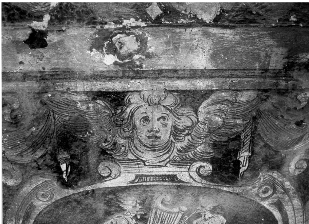
Palazzo Altini. Particolare della decorazione a graffito prima del restauro
