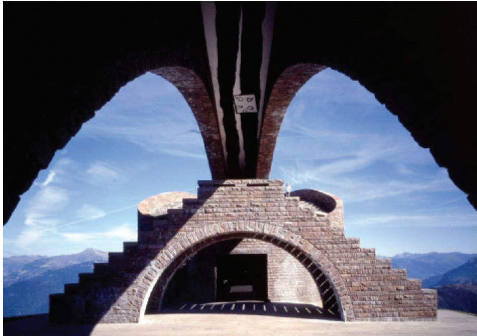
Fig. 6 - M. Botta. Cappella sul monte Tamaro, ingresso.
