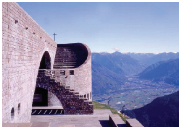
Fig. 5 - M. Botta. Cappella sul monte Tamaro, esterno.
