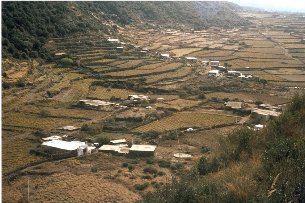
Un' immagine dei terrazzamenti dell'isola di Pantelleria con residenze rappresentate dai dammusi .
