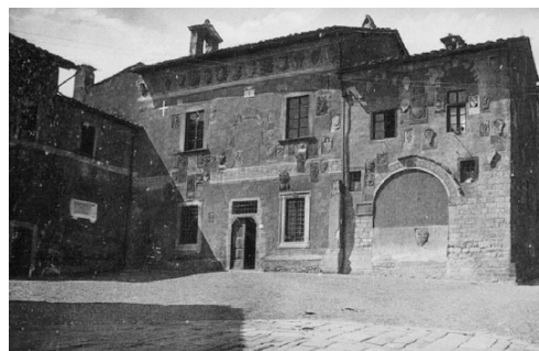
図3 アンギアーリ。1940年代のプレトリーオ宮の様子。正面玄関の右側に新たに設けられた窓が見える。 Fig.3 Fig. 3 - Anghiari. Il Palazzo Pretorio in un'immagine degli anni '40 del XX secolo. Si osserva la nuova finestra aperta a destra dell'ingresso principale.
